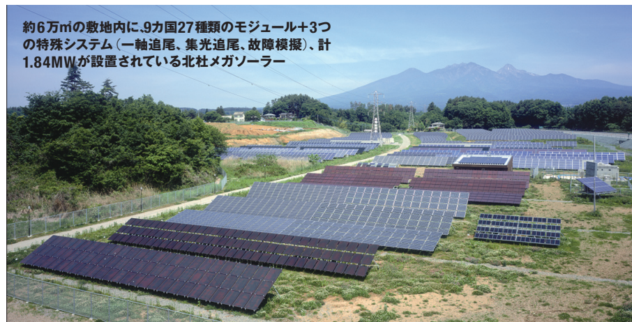
環境負荷低減や低コスト化のために架台の評価を実施。シンプルかつ美しいデザインを保ちながら計量化、コンクリート基礎が必要な通常架台と比べライフサイクルでのCO 2 排出量を約40%削減(基礎を含んだ比較)、地盤改良・残土処理を不要とした
