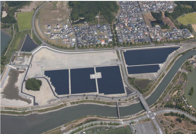
三交不動産(株)殿向け案件(三重県:5.2MW(運転中))航空写真
