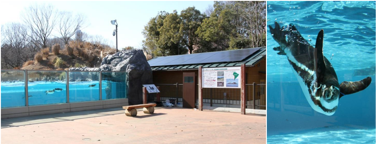
ソーラーフロンティアの CIS 薄膜太陽電池モジュールが設置された『ペンギンヒルズ』
