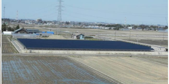
松山発電施設
