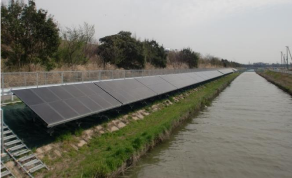
法面に設置された小松堀排水路発電施設
