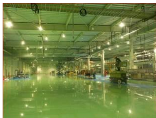
工場内部（生産ラインの搬入開始）
