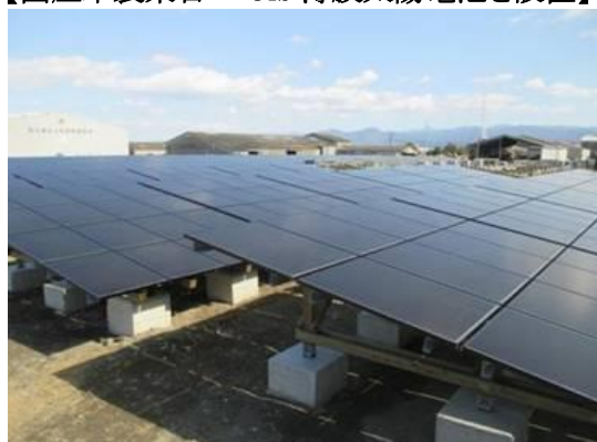
【国産木製架台へ CIS 薄膜太陽電池を設置】
