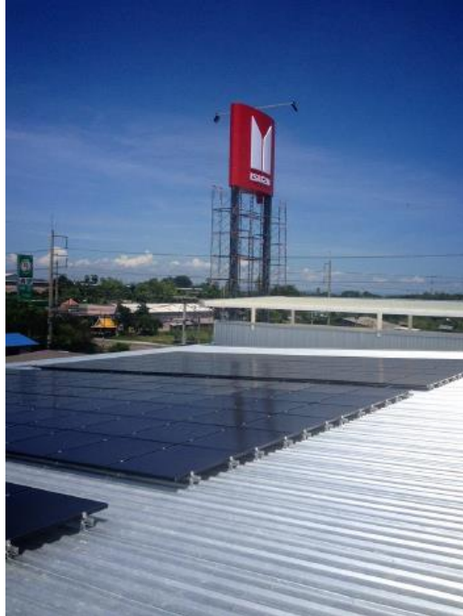
バンコク（タイ）のいすゞ自動車販売会社に設置された出力 50kW の CIS 薄膜太陽電池屋根設置型システム （写真：エナジープロコーポレーション社提供）
