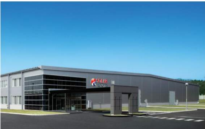
東北工場の外観
